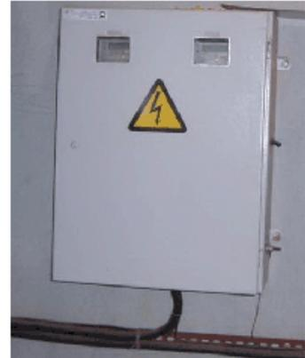
Во-вторых, какой мощности приборы сейчас включены. Пользуясь секундной стрелкой часов, определим, за сколько времени диск совершит, например, 40 оборотов. Это легко сделать, так как на диске имеется зачерненная полоска, которая отчетливо видна в окошечке всякий раз, когда диск заканчивает один оборот и начинает следующий. Допустим, на 40 оборотов затрачено 75 с. Затем читаем на счетчике, например, «1 кВт-ч — 5000 оборотов» и составляем пропорцию, исходя из следующего.
