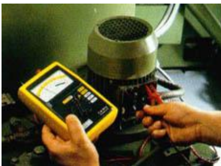
Тестирование изоляции на обмотках электромотора
